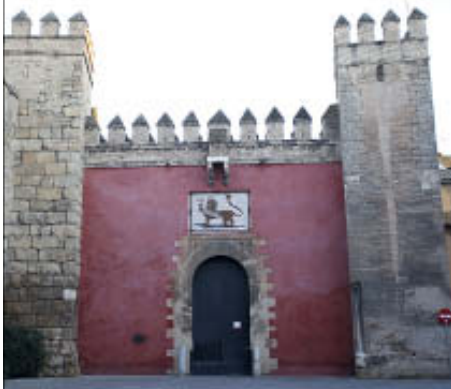
Muralla exterior y PUERTA DEL LEÓN , por la que se accede al recinto actualmente.
