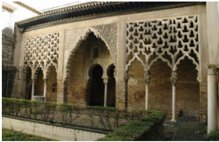
La composición del PATIO DEL YESO, con su gran arco central flanqueado por otros más pequeños, sería adoptada por los nazaríes.
